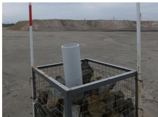
図4-1 ガス抜き管写真(無孔管)
