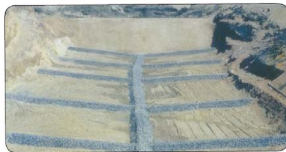
図 5-4 日本初の準好気性埋立 (新蒲田埋立場) 8)
